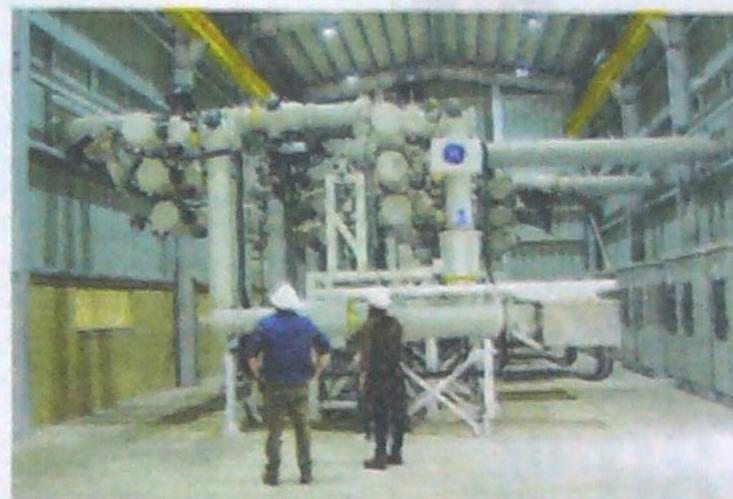
La subestación San Antonio está construida con equipos tipo GIS o subestación encapsulada, una tecnología de última generación.
