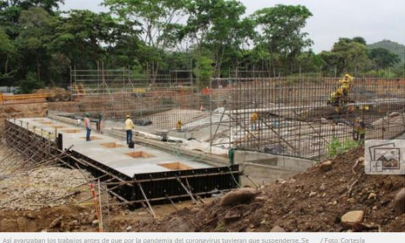
Así avanzaban los trabajos antes de que por la pandemia del coronavirus tuvieran que suspenderse. Se trabajaba en el desarenador, la instalación de la tubería y la casa de las bombas. / Foto: Cortesía
