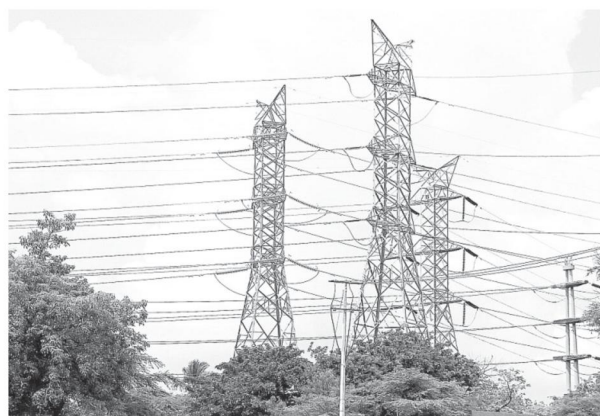
La línea de transmisión está en un 95% de avance y casi lista para entrar en operación el próximo 20 de septiembre.
