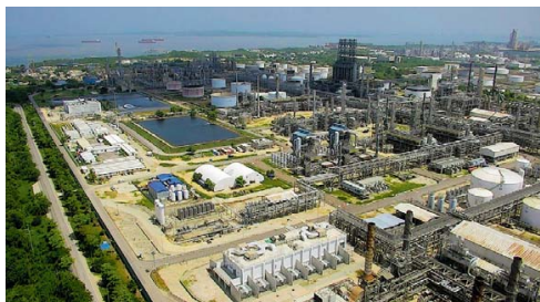
Vista aérea de las instalaciones de la refinería de Ecopetrol en Cartagena.
