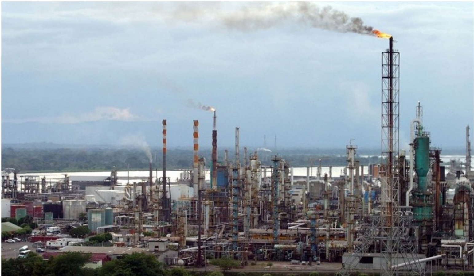
Refinería de Barrancabermeja . Foto: Colprensa
