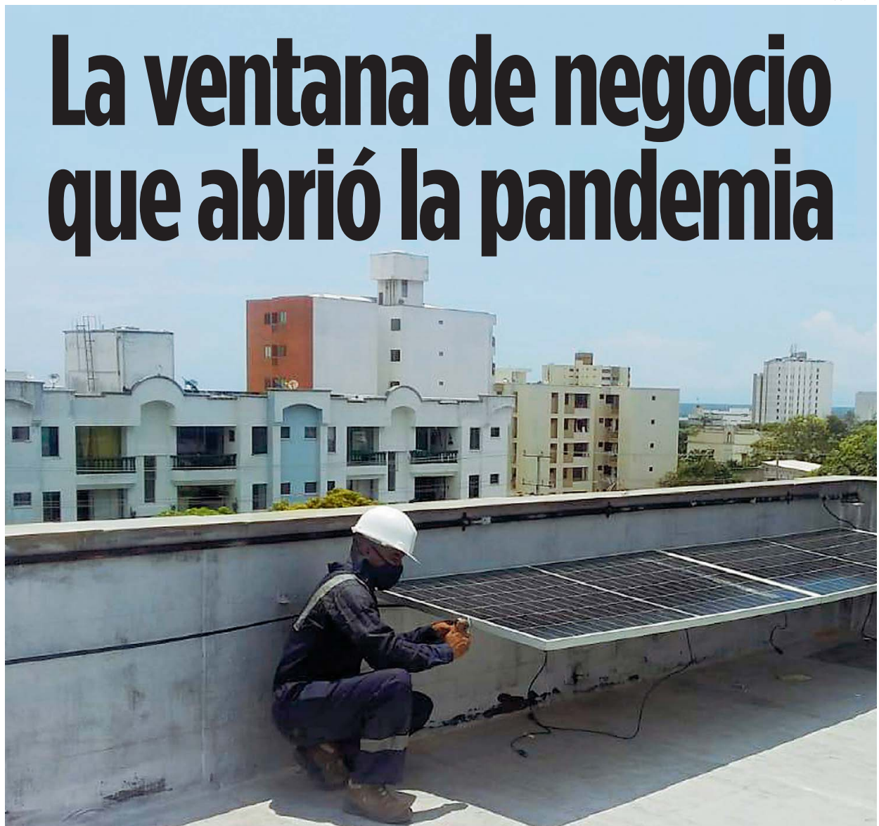
Un operario de Ingelnet instala un panel solar sobre el techo de una vivienda en el norte de Barranquilla.
