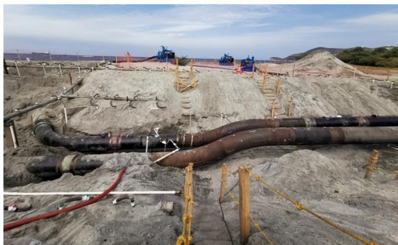
Las líneas transportan productos como nafta, diésel y gasolina desde la monoboya que queda costa afuera hasta los tanques de almacenamiento en el Terminal Marítimo de Pozos Colorados.
