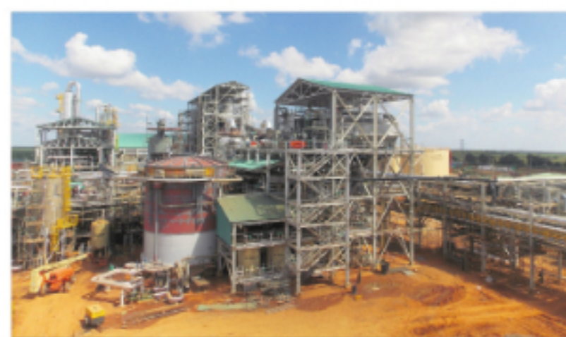
La construcción de la planta de Bioenergy tuvo serios tropiezos que generaron los primeros problemas.
