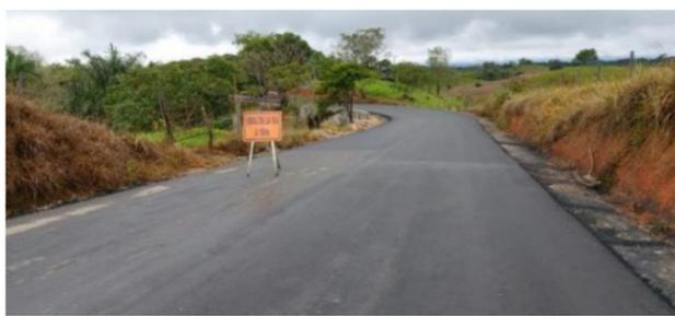
La obra incluye pavimento flexible, reemplazo de obras hidráulicas en mal estado, y adecuación y construcción de obras de drenaje.
