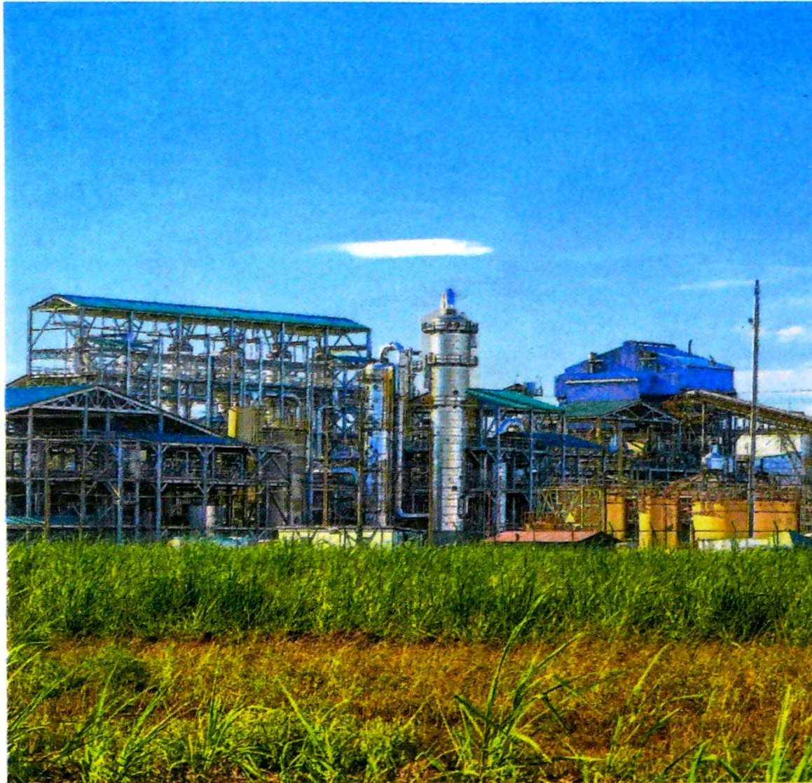
La planta comenzó su montaje en abril del 2010 y fue puesta en operación en abril de 2017.
