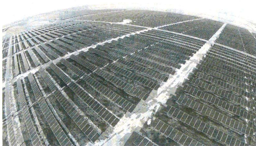
El complejo ‘La Sierpe’ contará con 65.000 paneles y una capacidad instalada de 20 Mw. AAGES
