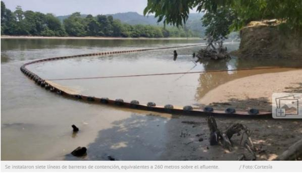
Se instalaron siete líneas de barreras de contención, equivalentes a 260 metros sobre el afluente. / Foto: Cortesía
