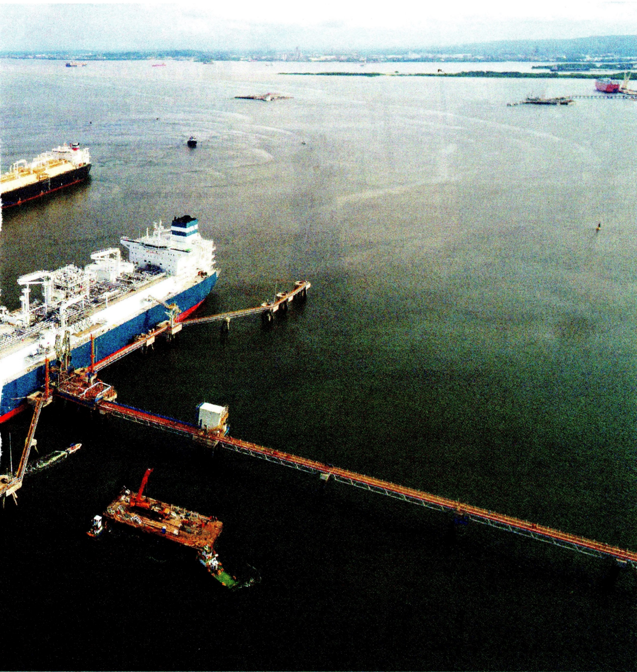
La regasificadora del Pacífico es un proyecto espejo a la regasificadora de Cartagena, en la foto, para la importación de gas licuado. Sobre ambas han recaído críticas. / Sociedad Portuaria El Cayao
