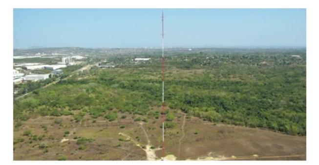
Ecopetrol inició pruebas piloto para medir el potencial de energía eólica en zonas cercanas a sus operaciones en Cartagena, con el objetivo de evaluar la viabilidad de construcción de parques eólicos que permitan en el futuro autoabastecer parte de la demanda energética de las operaciones de la compañía en esta región del país.
