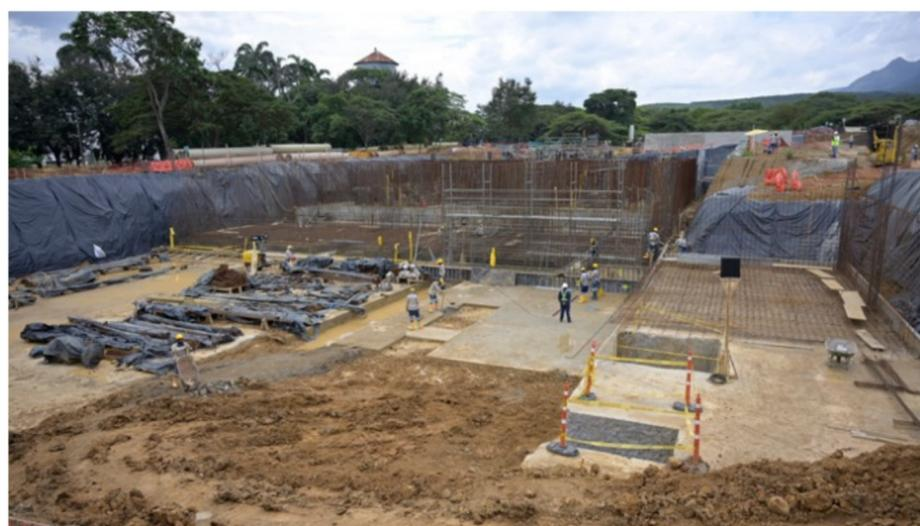
El subproyecto 1 cuenta con cámara de salida, obra anexa a la pileta de sello con capacidad de 2,95 metros cúbicos por segundo y conducción por gravedad desde la cámara de salida hasta el desarenador, en una longitud aproximada de 584 metros.
