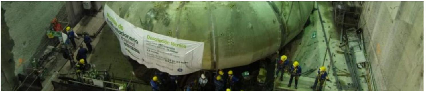
La cámara espiral y el anillo estacionario tienen un diámetro externo de 15 metros.
