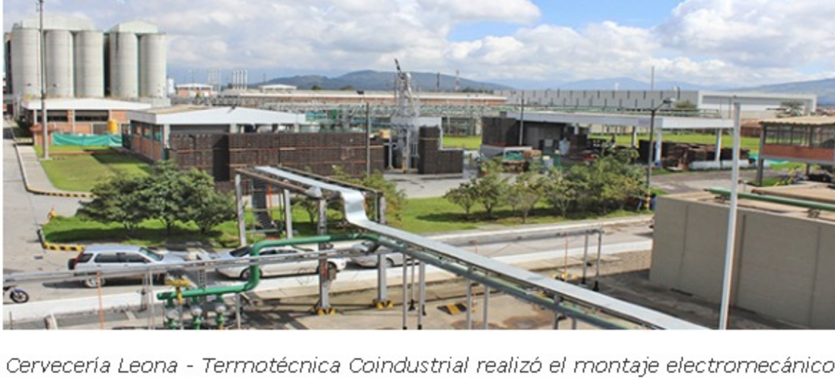
Cervecería Leona - Termotécnica Coindustrial realizó el montaje electromecánico
