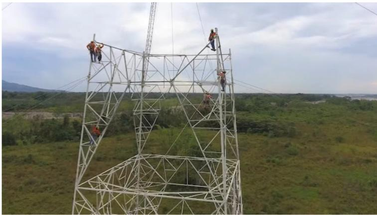
La obra que construyó el Grupo de Energía de Bogotá contempló la instalación de 76 torres eléctricas, 35 kilómetros de línea de transmisión eléctrica y 250 kilómetros de cableado, además de la ampliación de la subestación La Reforma 230 kV, en la capital del Meta.
