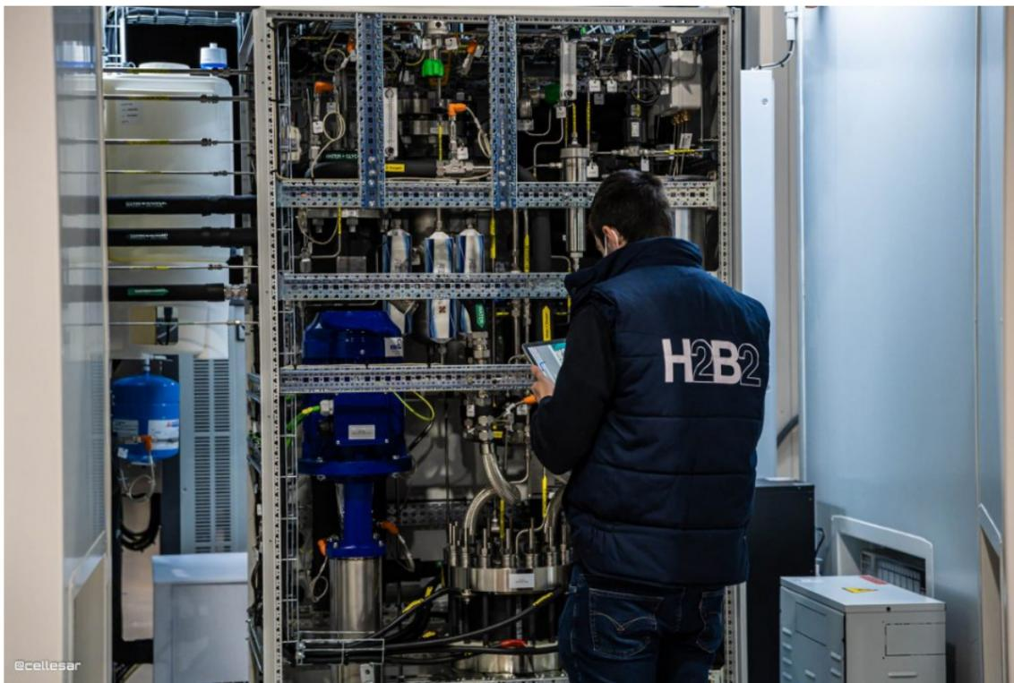
El **electrolizador** fabricado por H2B2, tiene la capacidad de dispensar hasta 647 kg de hidrógeno 100% renovable al mes en un funcionamiento continuo 24/7. “Esta tecnología puede evitar la emisión de hasta 6 toneladas de **CO2** al mes. A través de una fuerte inversión en I+D+i, nuestros electrolizadores permiten garantizar el camino de la descarbonización de los sectores clave en la transición energética: residencial, industrial y transporte y energía”, apunta Ferrera.
