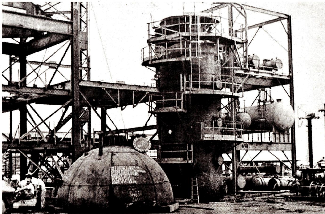
Construcción de la planta Cracking modelo IV en 1953 en la refinería de Barrancabermeja. FOTO: CORTESÍA ARCHIVO PEDRO CHAPARRO
