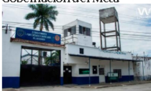
Muros de la cárcel de Villavicencio estarían a
