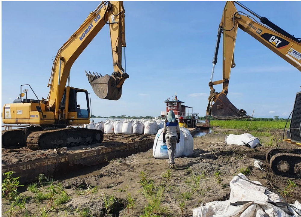
Obras Sitio Nuevo en Puerto Wilches, Santander. Foto: Alcaldía de Puerto Wilches.
