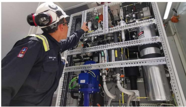
El piloto cuenta con un electrolizador de 50 kilovatios que se abastece de la energía que producen 270 paneles instalados en terrenos de [redacted] - Foto: Foto: [redacted]
