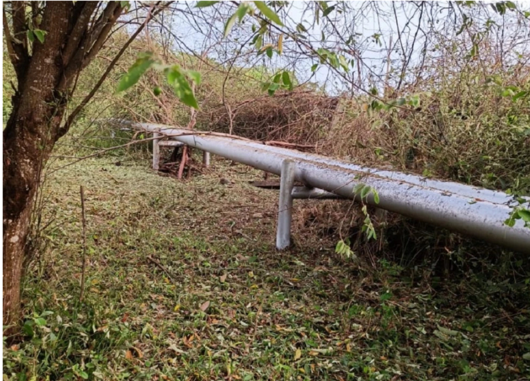
BLU Radio. Atentado gasoducto en Barrancabermeja / FOTO: Ecopetrol
