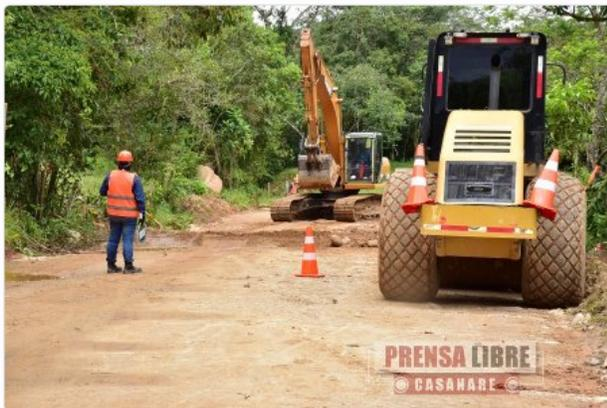
La intervención incluye la construcción de la estructura de pavimento, dos sectores con carpeta asfáltica y un sector intermedio con carpeta de concreto hidráulico; demarcación, señalización vial vertical y horizontal, elementos de contención vial y de drenaje, cunetas, alcantarillas y obras de geotecnia.
