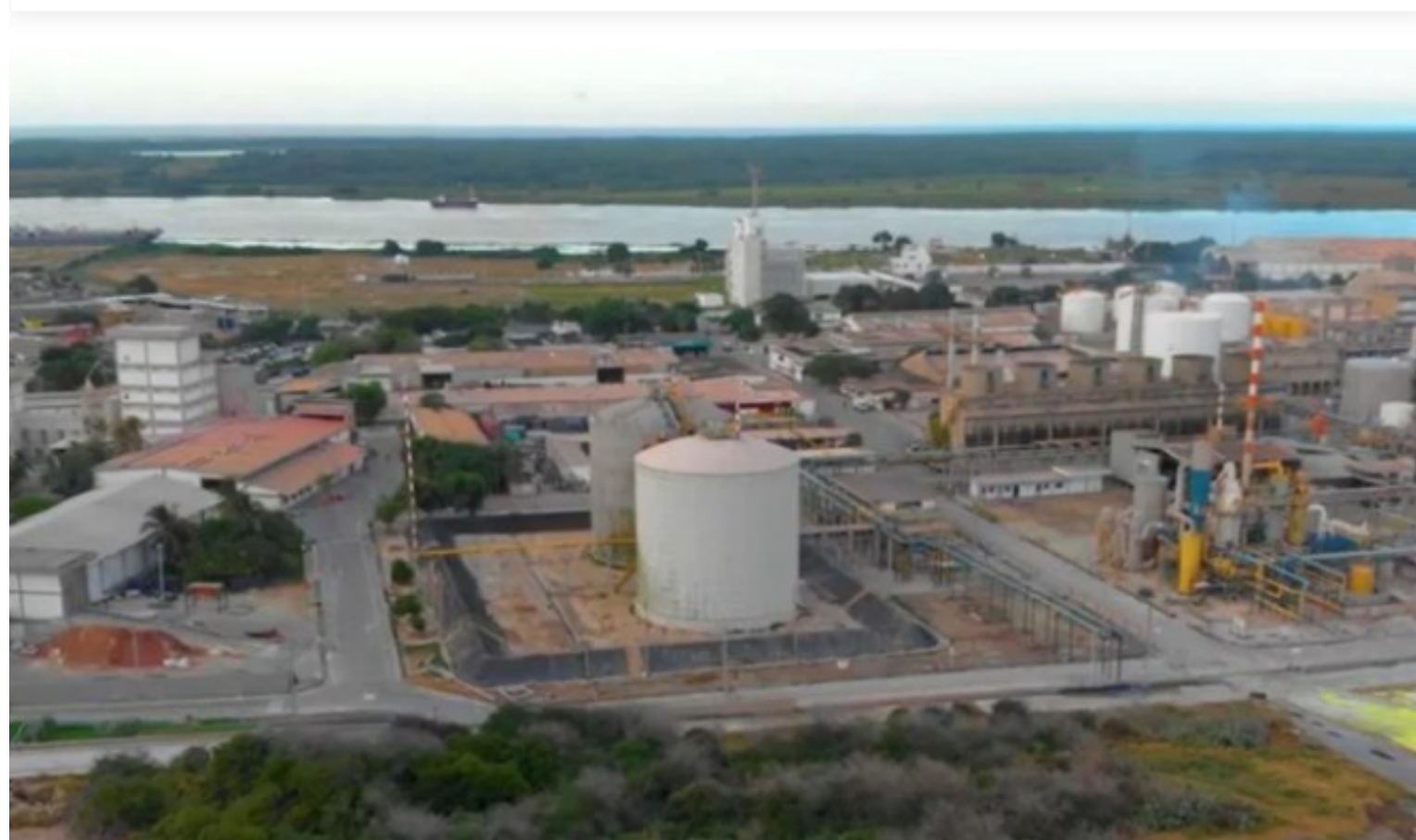
Planta de la empresa ubicada en Barranquilla.
