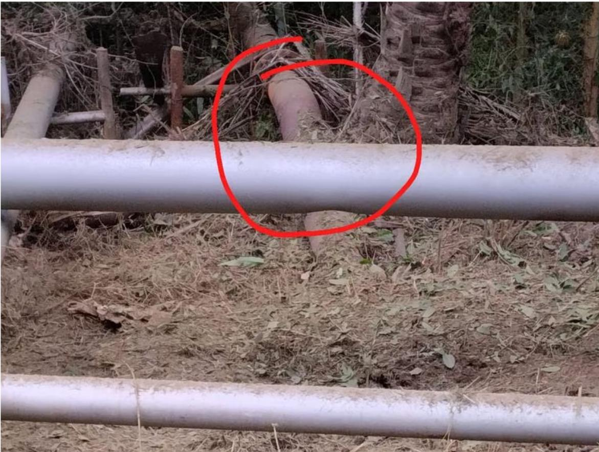
Resultó afectada la troncal de inyección de 12 pulgadas de la Planta de Inyección de Agua. - Foto: Suministrada.
