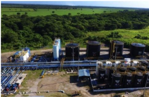
El vicepresidente de la Gerencia de **Ecopetrol** Llanos, Edgar Partenina Blanco, explicó que el pozo productor extrae fluido a una profundidad de 3,5 kilómetros. El calor del fluido geotérmico se utilizará para vaporizar un gas secundario, lo que indica que se planea una planta de energía binaria para el desarrollo.
