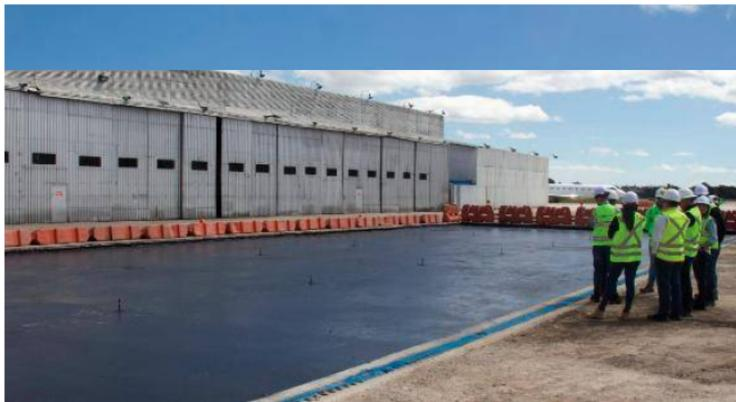
Es la primera vez en el país que se utiliza pavimento con plástico reciclado para la pavimentación de una calle de rodaje en una terminal aérea. FOTO tomada de Twitter
