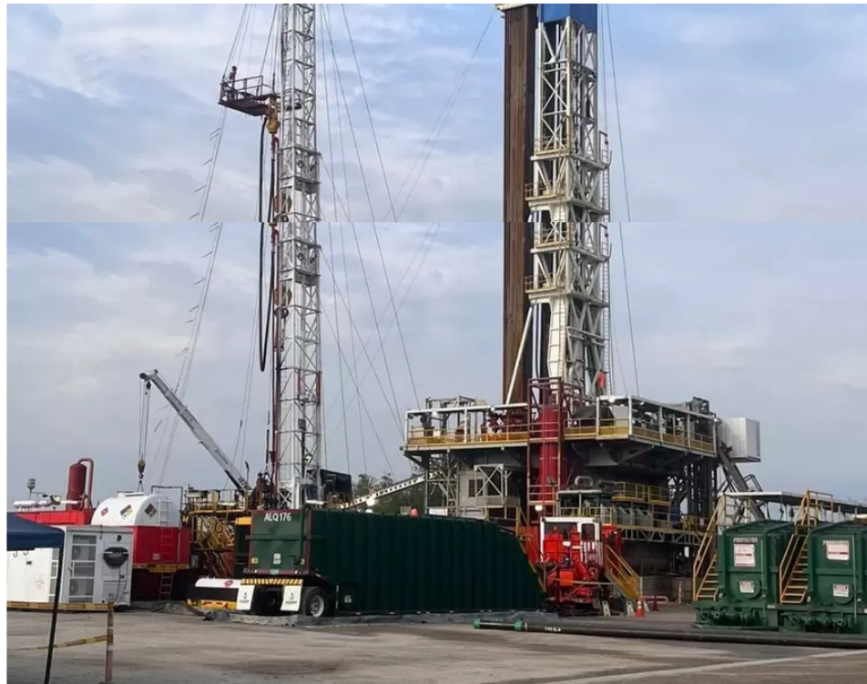
Pozo Tinamú-1 de Ecopetrol y Repsol.
