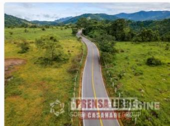
La primera obra entregada fue la pavimentación de 2.9 kilómetros del anillo vial Unión Charte – Cupiagua en la vereda Plan Brisas, que incluyó la pavimentación en carpeta asfáltica, demarcación, señalización y elementos de drenaje.
