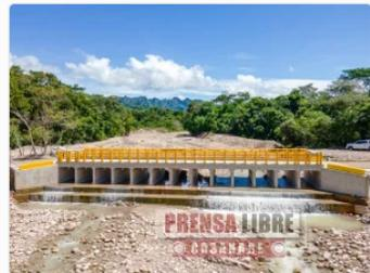
La segunda obra entregada fue la construcción de un box culvert sobre la quebrada La Calle, ubicada en la vereda La Cachiza. Esta estructura, que cuenta con una longitud de 32 metros y 13 módulos de concreto, representa una inversión de **Ecopetrol** superior a los \$3.571 millones.
