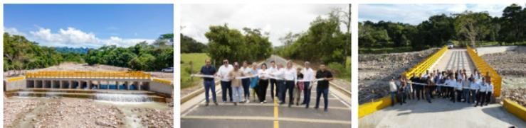
La segunda obra consistió en la construcción de un box culvert sobre la quebrada La Calle, ubicada en la vereda La Cachiza. Esta estructura, con una longitud de 32 metros y 12 módulos de concreto, representó una inversión superior a los \$2.571 millones.
