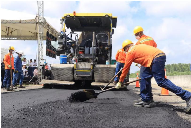
Con el asfalto hecho con plástico reciclado se bajan los niveles de contaminación hasta en un 10%.//Cortesia.
