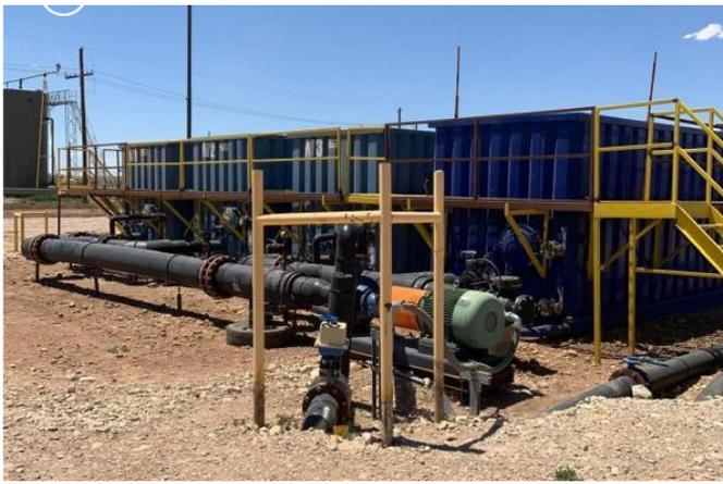
Imagen 1: tanques donde se trata el agua recirculada que se usa para el fracturamiento de los pozos. FOTO:EL TIEMPO
