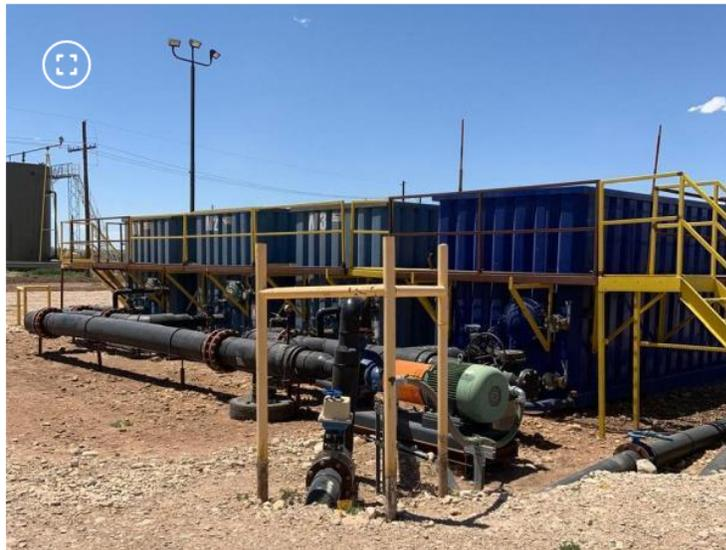
Imagen 1: tanques donde se trata el agua recirculada que se usa para el fracturamiento de los pozos. FOTO:EL TIEMPO
