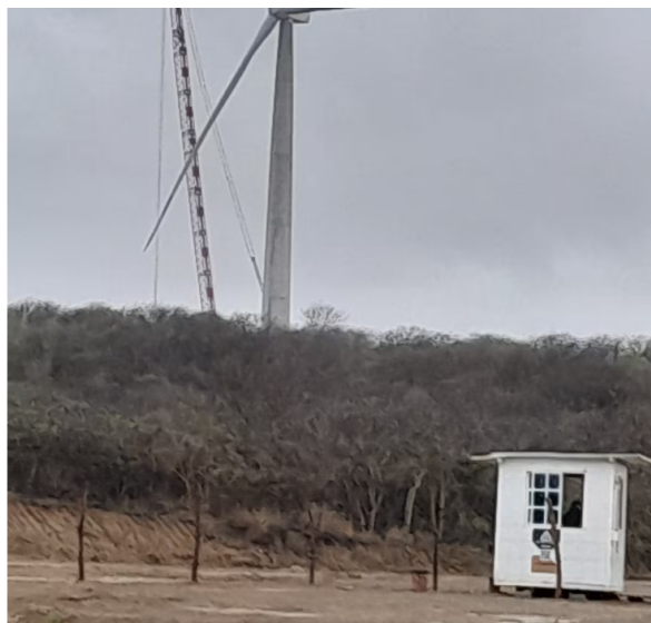
Proyecto de energía eólica Carreto, en el municipio de Juan de Acosta, departamento del Atlántico, visto desde la Vía del Mar. // HFA - EU.
