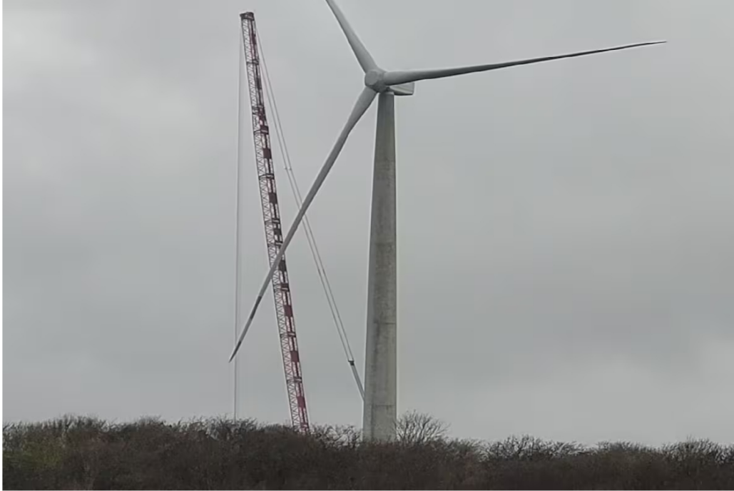
Instalación del primer aerogenerador del proyecto Carreto, de Celsia, en Juan de Acosta, Atlántico. //Cortesía Óscar Lora.
