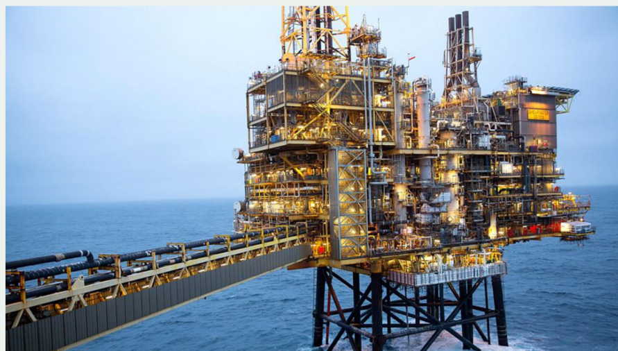
Plataforma marina del Mar del Norte de Shell.
