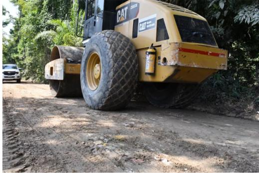
El mantenimiento, con una inversión superior a los \$3.062 millones, incluye reparación de fallos y limpieza y reconformación del terreno con rebase y subbase. Suministrada/VANGUARDIA
