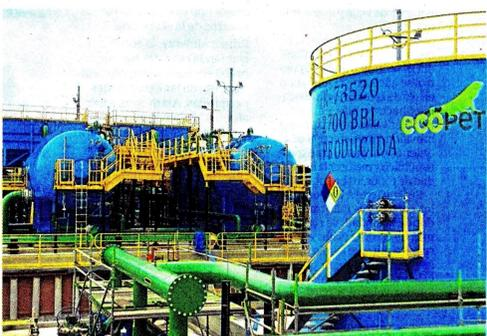
Sistema de tratamiento de agua de producción (Stap) utilizado en el campo Castilla (Meta), que tendrá una capacidad total para 120.000 barriles de agua por día. Foto: Ecopetrol.
