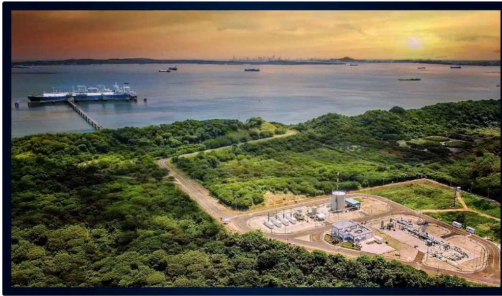
Planta de regasificación Spec | Crédito: SpecIng
