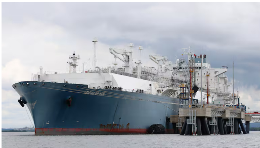
En la unidad flotante de SPEC, en Barú (Bahía de Cartagena) se realizan las maniobras de descargue de gas, desde los buques metaneros. //Julio Castaño.
