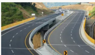
Colombia necesita $19 billones para ponerse al día con las obras del Plan Maestro de Transporte
