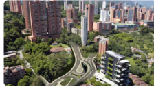
Alcaldía de Medellín inicia obras en esta importante calle de El Poblado: vías alternas y fechas clave
