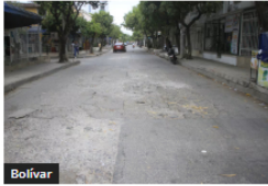
Bolívar Rehabilitarán más vías en la Localidad 2 de Cartagena
