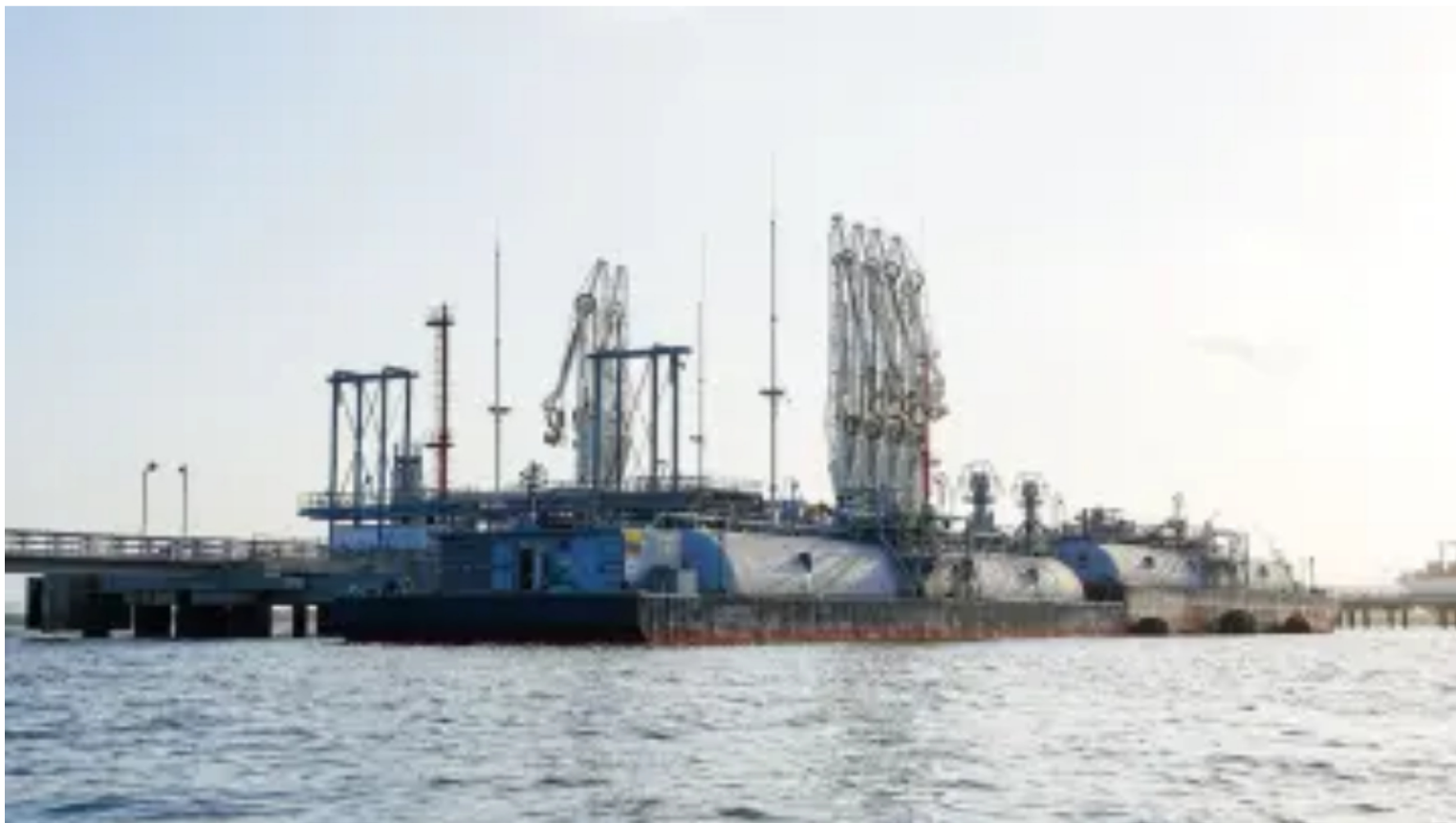
Muelle de hidrocarburos de Puerto Bahía. Suministrada.
