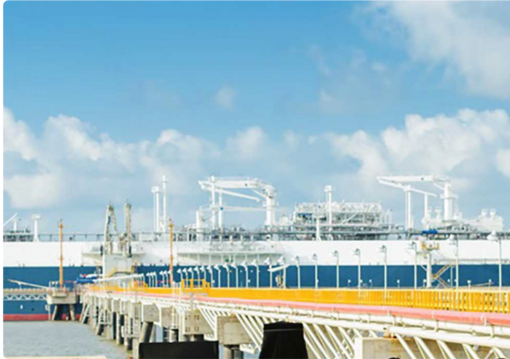
Panorámica del proyecto de la planta de regasificación de Ecopetrol en Coveñas, Sucre.
