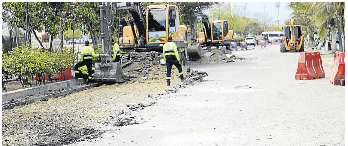
Obras del ‘Corredor Histórico’, aledaño al Parque La Marina. //FOTO: JULIO CASTAÑO - EL UNIVERSAL
