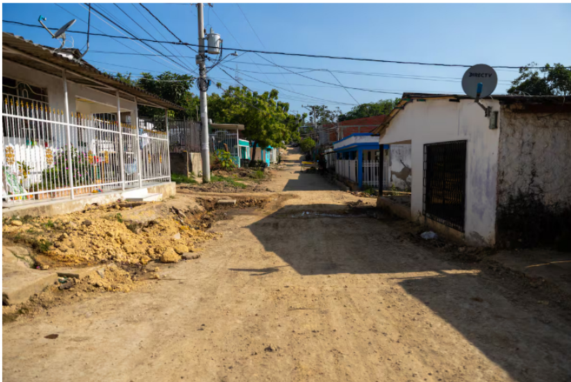
Obras en Arroz Barato. // Foto: cortesía - Ecopetrol .
