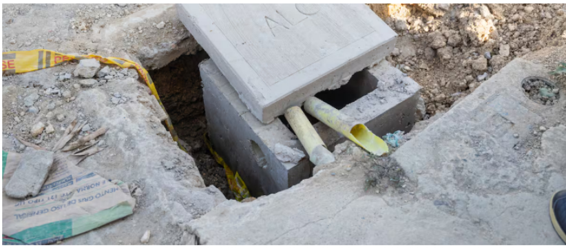
Obras en Arroz Barato. // Foto: cortesía - Ecopetrol.
