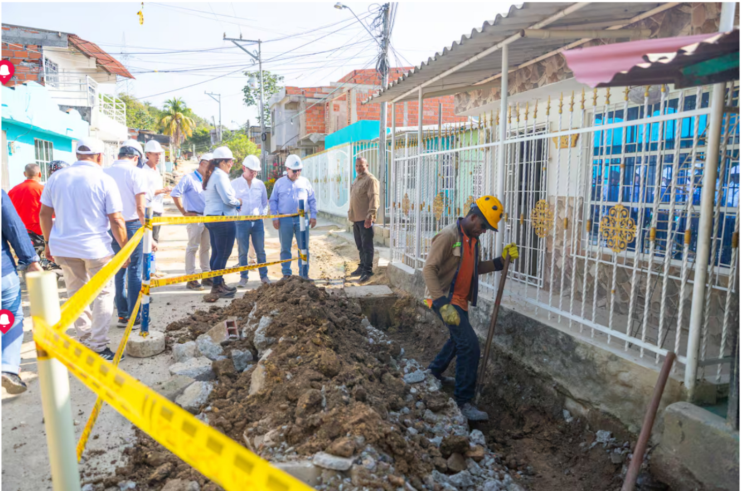
Obras en Arroz Barato. // Foto: cortesía - Ecopetrol
