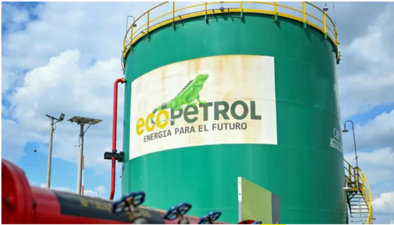
Imagen de un tanque de almacenamiento de petróleo crudo de Ecopetrol . Foto: AFP
