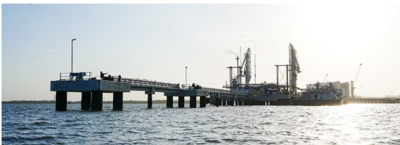
Infraestructura para recibir buques metaneros en las instalaciones de Puerto Bahía. //Foto Cortesía
